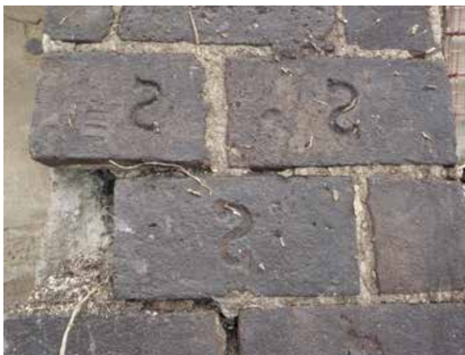
Obr. 22. Cihly s kolkem S (stranově obráceným) ze Strahovské(?) cihelny, vel. 29,5 × 14,5 × 6,5 cm, negat. reliéf. Nalezeno: opěrný pilíř v zahradě objektu čp. 192 v Thunovské ulici na Malé Straně, archeologický výzkum NPÚ v Praze č. 2011/3 (foto J. Zavřel, 2013).
